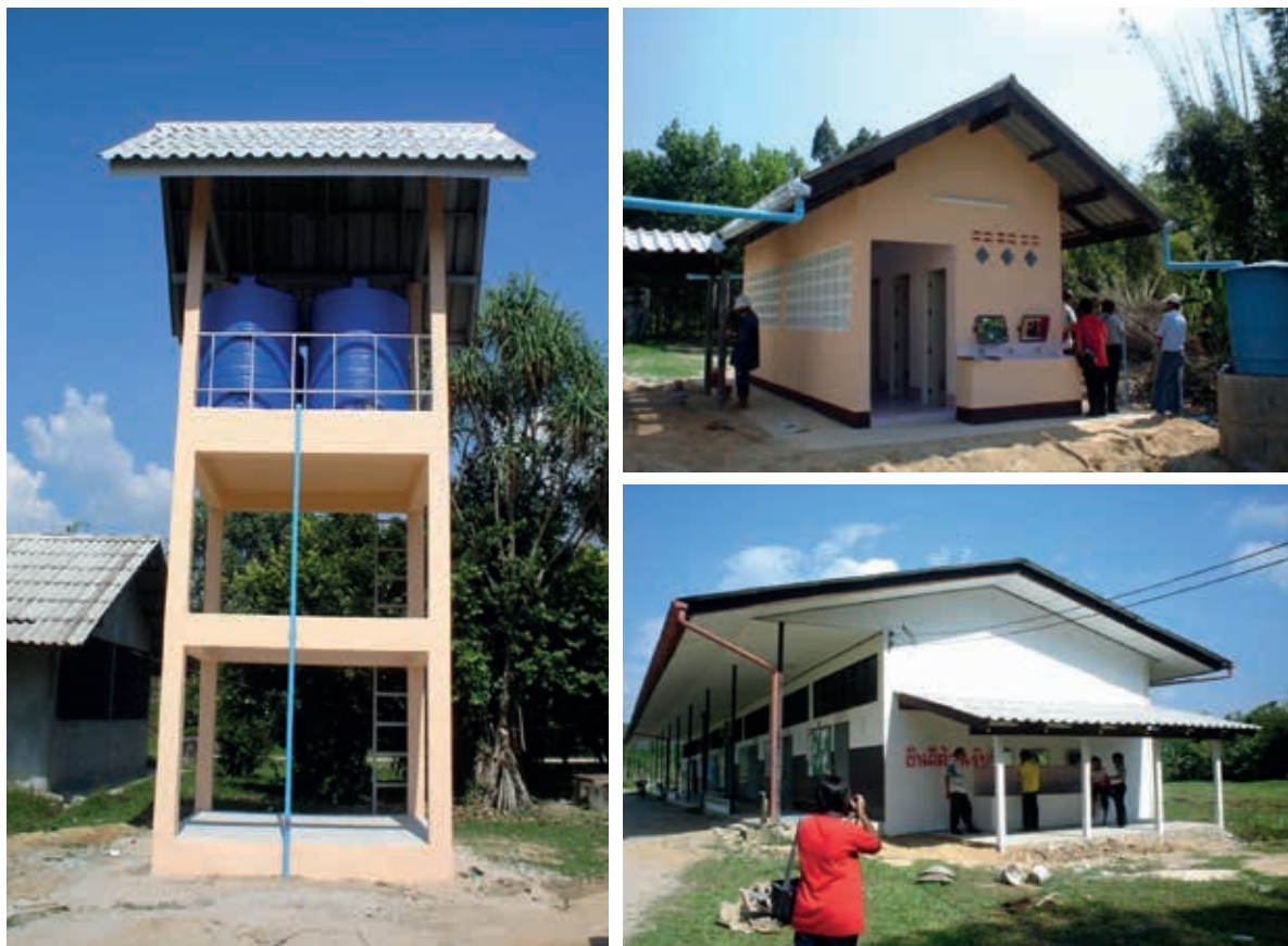
การสร้างห้องน้ำ-ห้องส้วม การปรับปรุงระบบน้ำโรงเรียนนิคมสร้างตนเอง อำเภอท้ายเหมือง จังหวัดพังงา
