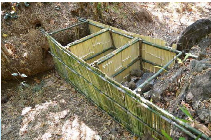
ภาพที่ 16: ฝายเพื่อชะลอน้ำและสร้างความชุ่มชื้นให้กับผืนป่า ที่มา: สำนักงานคณะกรรมการพิเศษเพื่อประสานงานโครงการอันเนื่องมาจากพระราชดำริ
