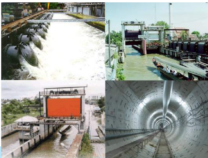
ภาพที่ 16: ตัวอย่างการป้องกันและลดผลกระทบจากน้ำท่วมในกรุงเทพมหานคร (สถานีสูบน้ำ ประตูระบายน้ำ อุโมงค์ยักษ์) ที่มา: สำนักงานระบายน้ำ กรุงเทพมหานคร
