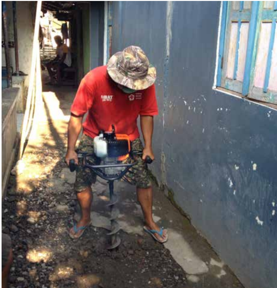
Anggota Tim SIBAT membuat lubang biopori dengan menggunakan mesin bor agar lebih cepat.
