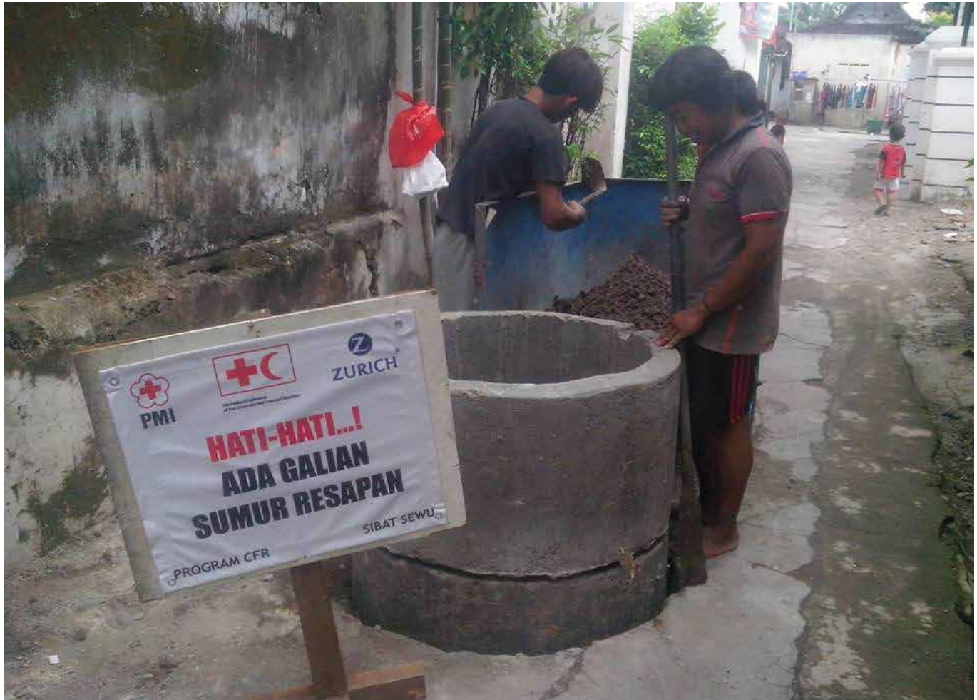
Anggota Tim SIBAT Kelurahan Sewu, Surakarta, sedang menyiapkan ring beton sebagai material pembuatan sumur resapan.
