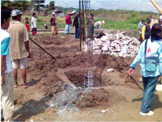
Foto 9.1. Mitigasi struktural pembuatan tiang pancang penahan eceng gondok, Kelurahan Laelo, Kab. Wajo, Sulawesi Selatan
